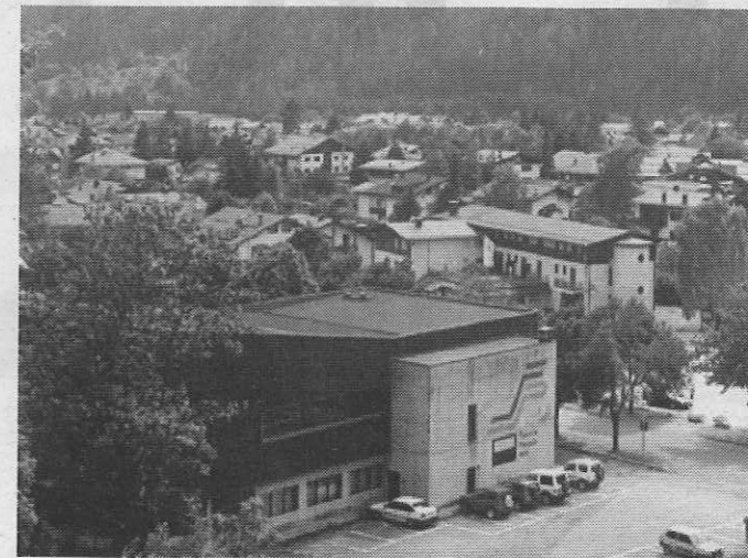
In primo piano, la sede delle Funivie Pinzolo spa
