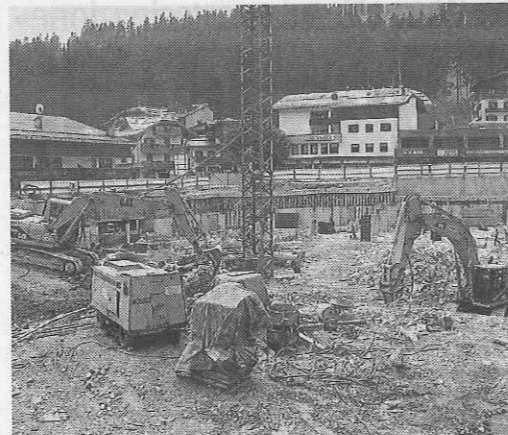
Il cantiere di Piazza Brenta Alta
