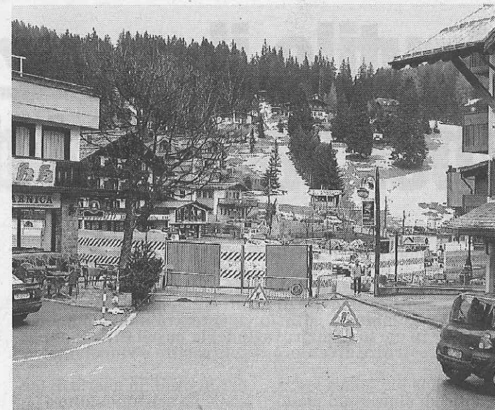
Chiude piazza Brenta Alta e apre il cantiere
